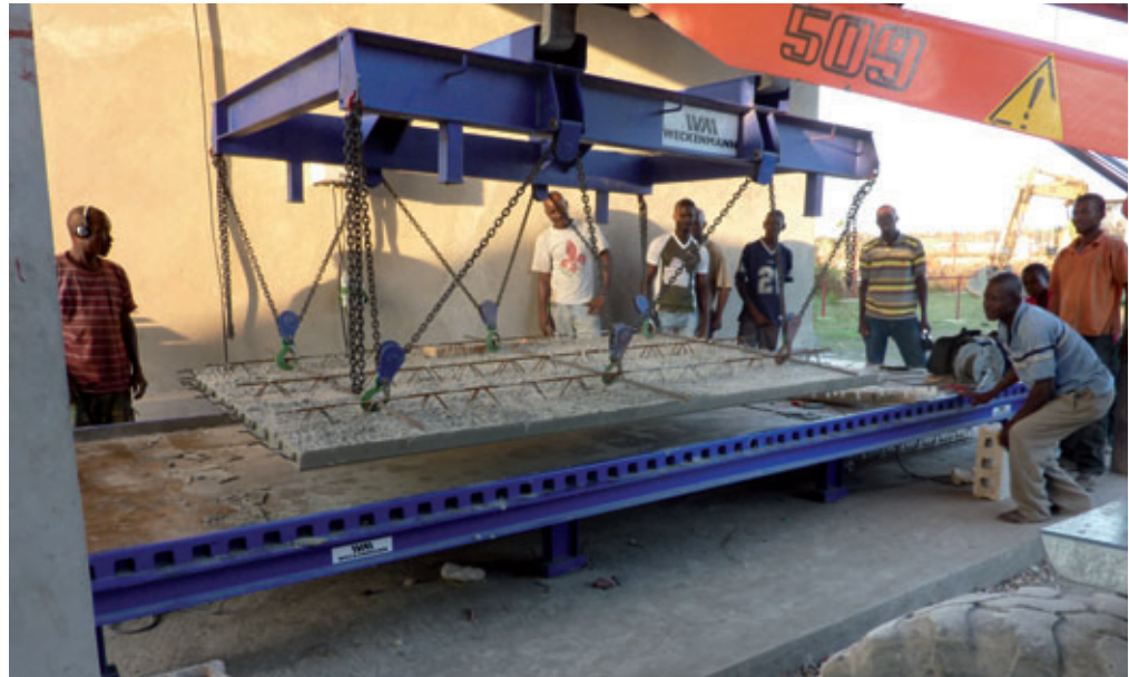
Auf einem stationären Fertigungstisch, den die Firma Weckenmann aus Deutschland geliefert hat, werden Elementdecken produziert. (Bilder: Pro Haiti)
