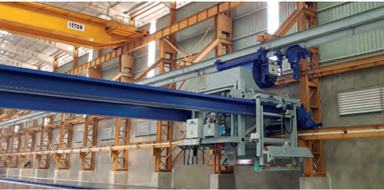
混凝土输送过程中带斗式输送机的半龙门式混凝土摊铺机
